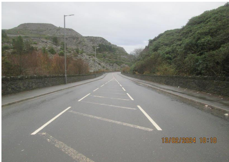
Llun 2: Troedffyrdd presennol yr A470(T) a waliau terfyn i'r de o Gyffordd Llechwedd.
